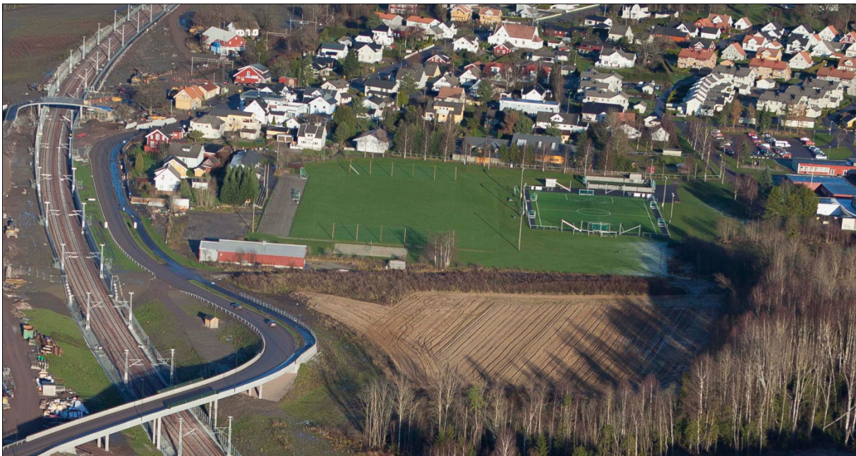
Illustrasjonsfoto som viser situasjonen i Barkåker, den nylig utbygde parsellen på Vestfoldbanen. Forbi tettstedet ligger dobbeltsporet i dyp skjæring. Foto: Jarle Foss/Jernbaneverket.
