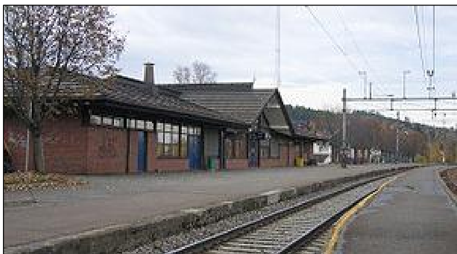
Figur 10-2 Moelv stasjon. Foto: Cato Edvardsen
