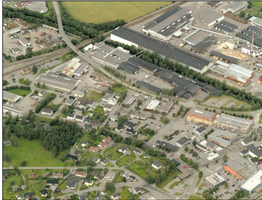
Figur 9-1 Foto Ringsaker kommune/Blom
