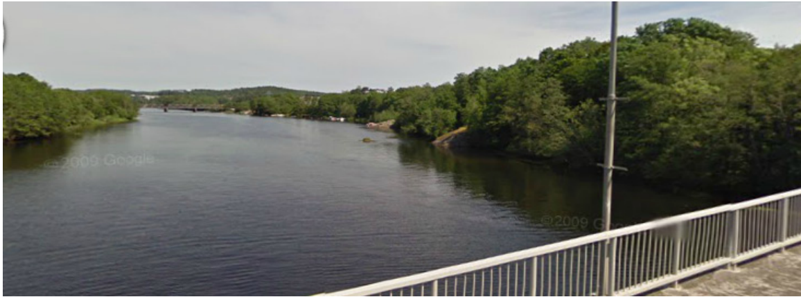
Bilde fra Gloppe bru som viser hvordan eksisterende lave jernbanebru ligger godt integrert i landskapsbildet. Kilde: bilde fra Googlemaps /StreetView
