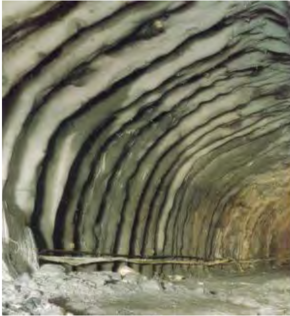
Figur 29 viser til venstre armerte sprøytebetongbuer sett innenfra tunnelen. Til høyre kan man se et snitt av en sprøytebetongbue (Sve, et al., 2008).
