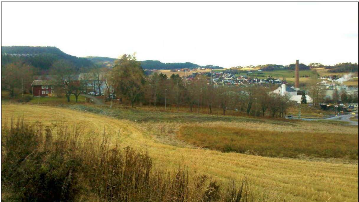
Figur 5: Bildet er tatt i sør-vestlig retning, og viser området traséen vil gå inn i løsmasseskjæring. Traséen kommer fra høyre side på bildet og vil gå inn under gården til venstre i bildet (Foto: Kristian Dahl).
