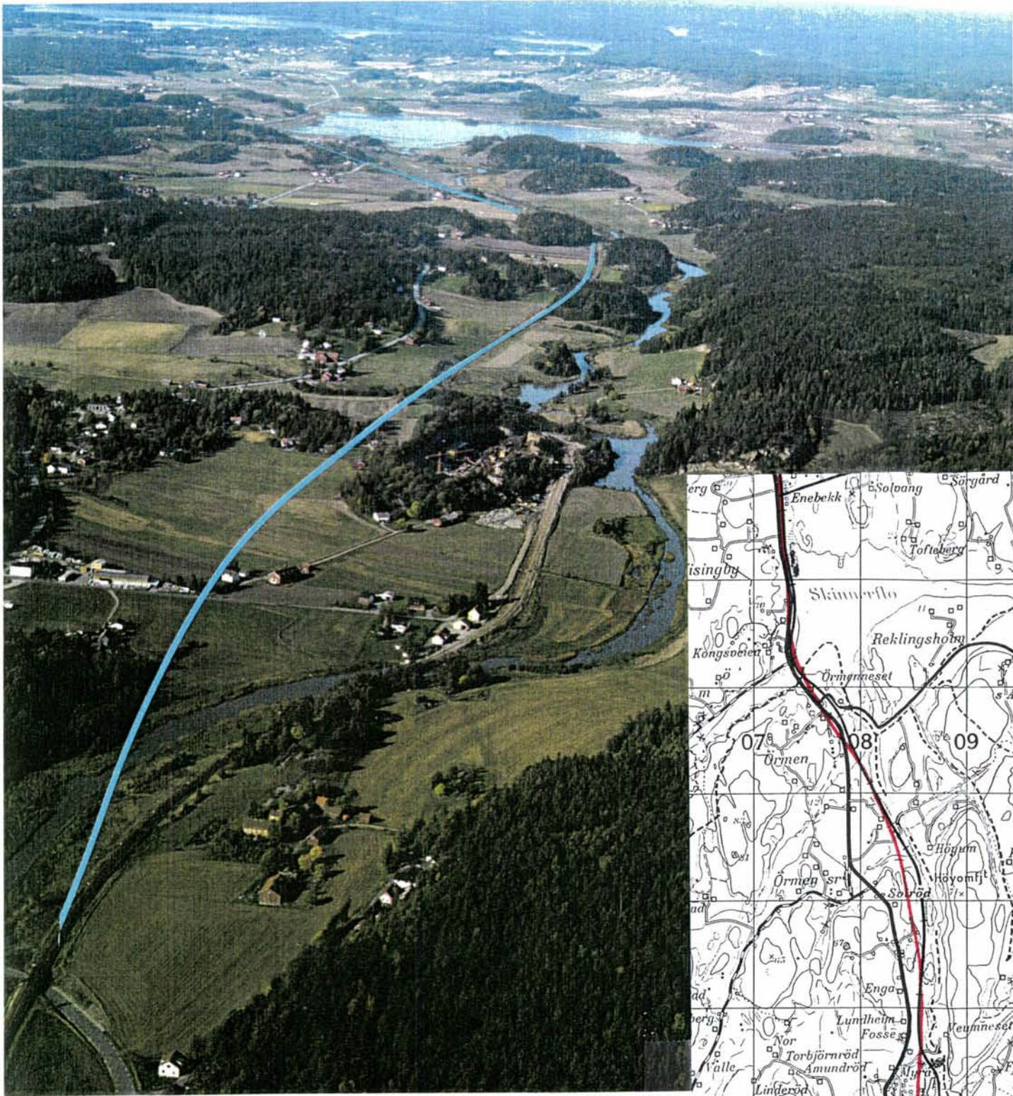
Seutelva, Onsøy stasjon sett fra S (A4)
