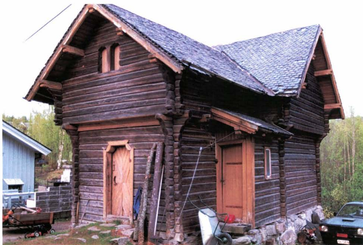
Foto 28: Ved Nysted vokterbolig sør for Koppang stasjon, km 246,25, finner vi dette eksemplaret av Blix' små bryggerhus/uthus, antakelig det siste gjenværende i autentisk utgave. En ombygd utgave er i bruk som stasjonsbygning på Rasta (foto 16 og 18). En tilsvarende uthusbygning, og et større bryggerhus, sto tidligere også på Koppang stasjon (jfr. figur 4).
