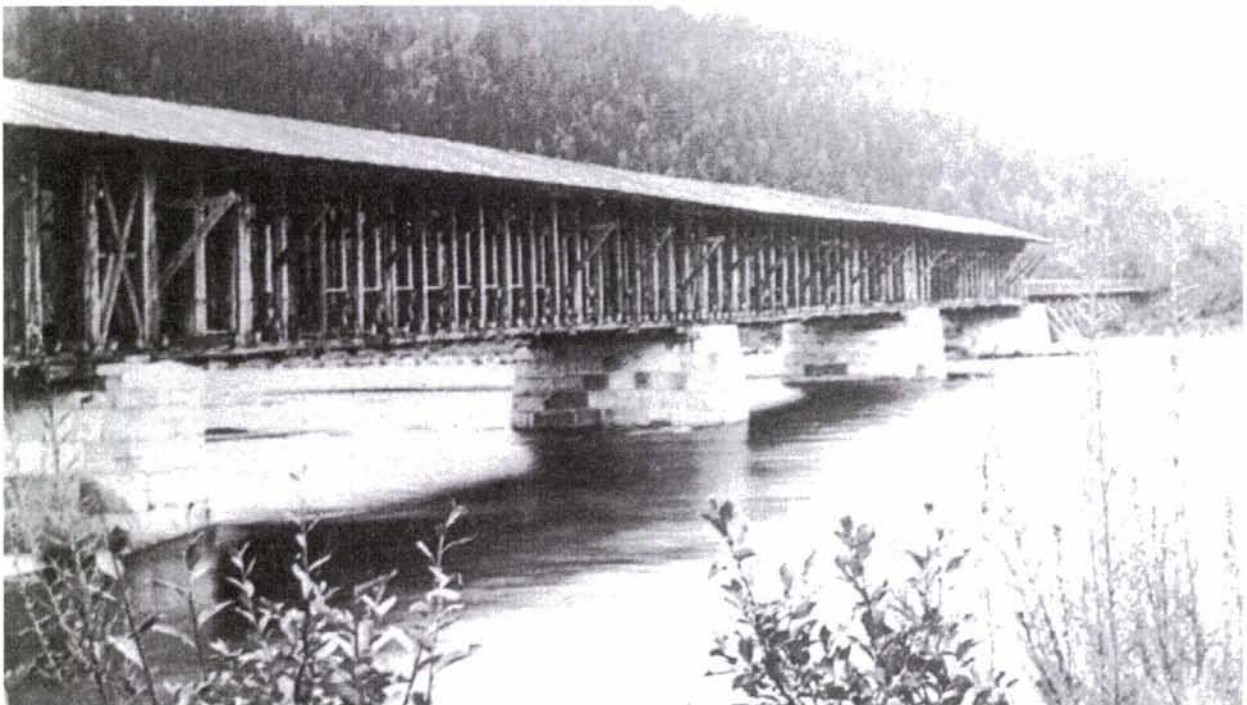
Foto 74: Den 247 meter lange trebrua over Gaula ved Støren ble midlertidig forsterket i forbindelse med omleggingen til normalspor i 1941, men først avløst av ei stålbru i 1951(!). Den for oss fremmedartede takkonstruksjonen var tidligere vanlig på trebruer. En tilsvarende bru bygget over Gaulfossen på Størenbanen i 1864 ble tatt av flom i 1918.
