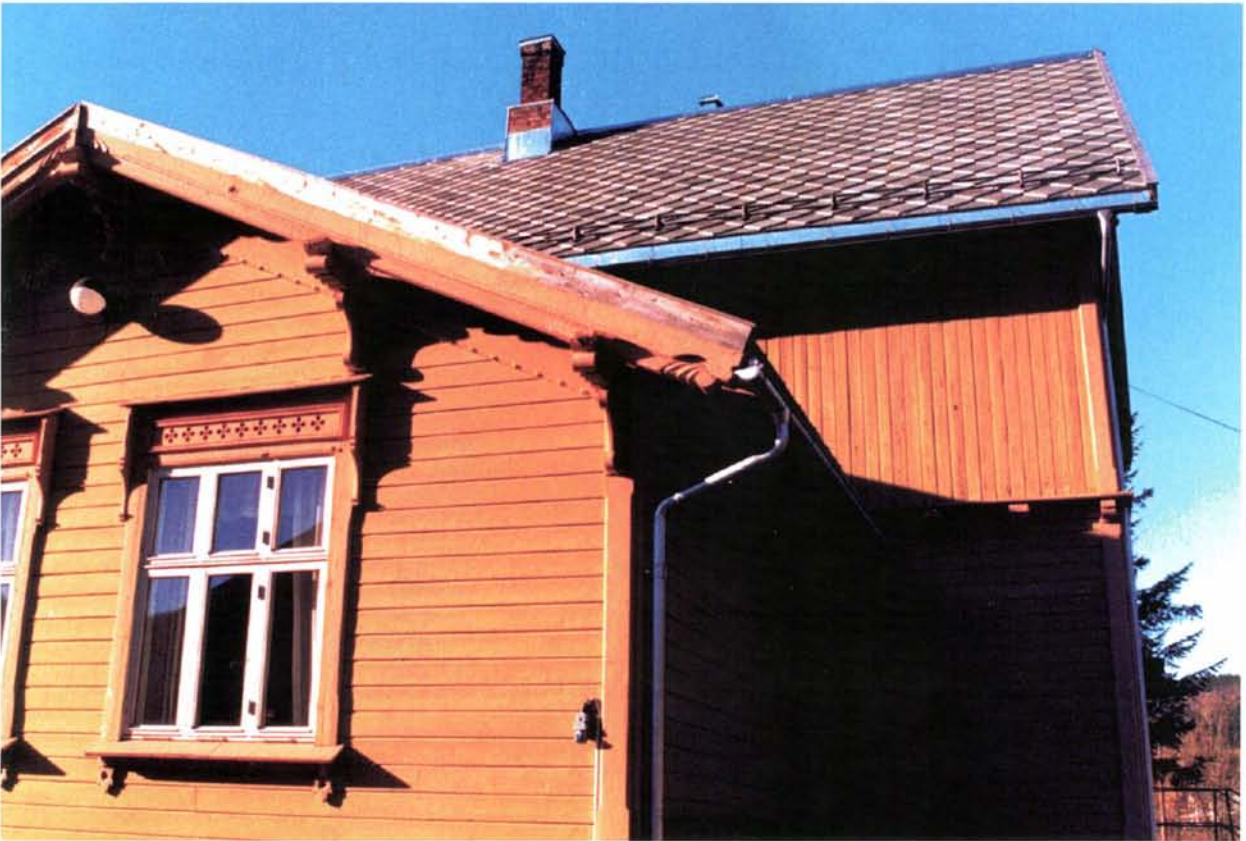
Foto 50 og 51: Bortsett fra dører og noen vinduer som er fornyet og endret er Singsås stasjonsbygningens eksteriør med dekorative elementer intakt. I 1998/99 ble bygningens skifertak restaurert og tilbakeført. Ødelagte takrenner ble erstattet av nye med tilsvarende materiale og form som de gamle. Dette arbeidet ble utført av NSB BA Eiendom.
