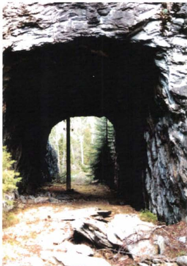
Foto 62 - 65: De seks nedlagte tunnelene i Drøyliene har alle sitt originale, råsprengte profil med langsgående, oppmurte drenggrøfter fra Rørosbanens smalsporperiode i behold. Bevart (og i fortsatt bruk!) er også den gamle trådkursen for telefon og telegraf. Parsellen har stor anleggshistorisk verdi og anbefales fredet etter kulturminneloven
