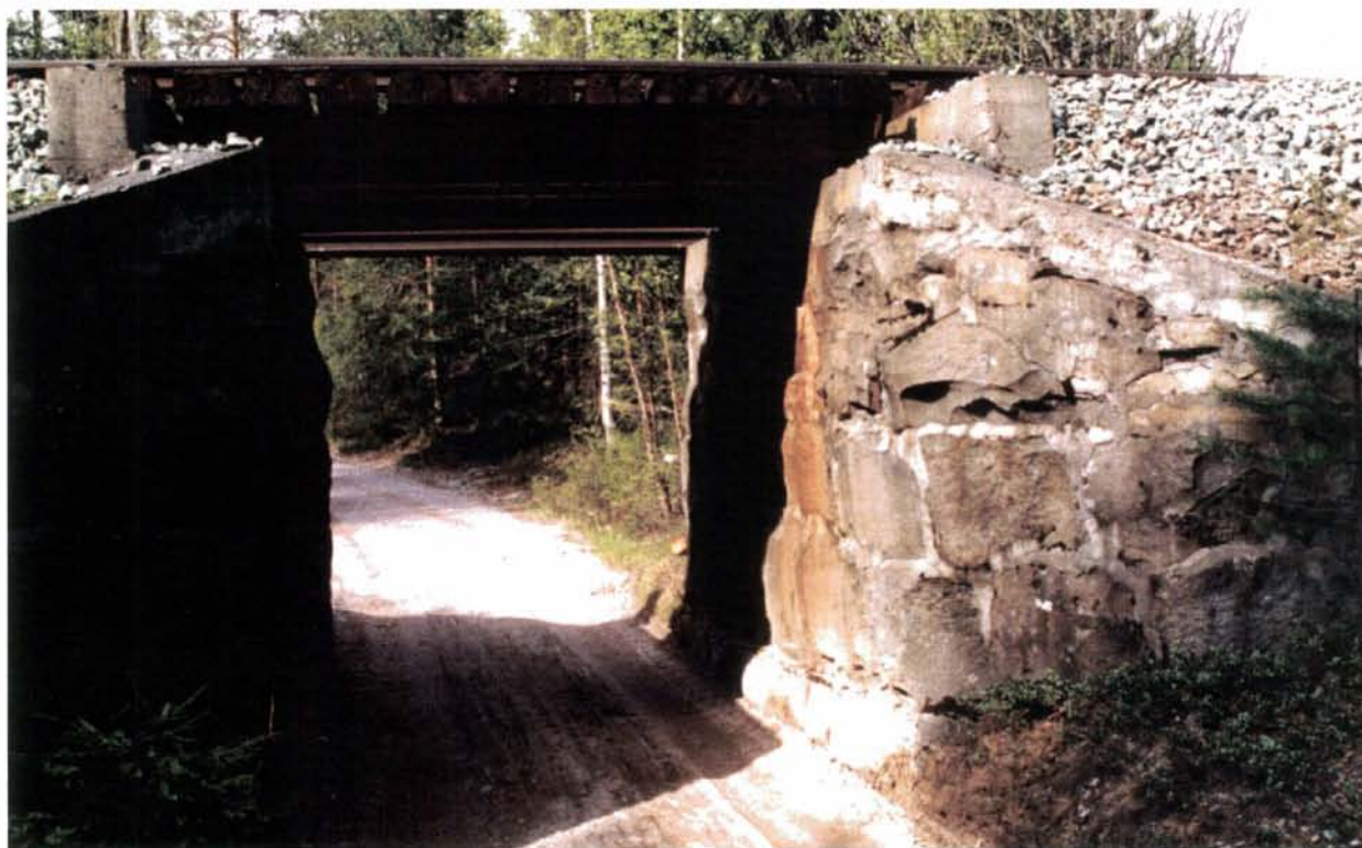
Foto 71: Undergang ved Opphus, km 212,45, med stålbjelker ("tvillingbærere") fra sporombyggingen i 1931 i behold. Både brubane og steinkar bør forsøkes bevart som tekniske minner. Det er imidlertid ikke aktuelt å verne noen av disse korte stålbruene på Rørosbanen. Til gjengjeld må man arbeide mot å finne fram til en bruoverbygning som ikke bryter så radikalt med det gamle murverket som dagens betongtrau gjør (foto 73).
