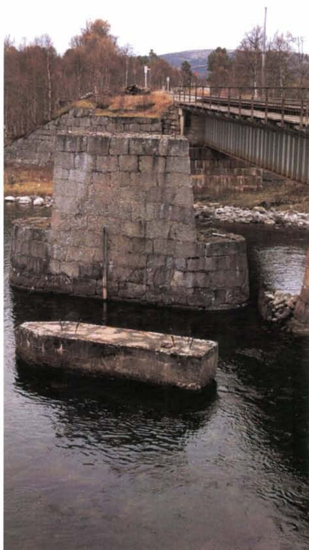
Foto 78: Nåværende bru over Glomma ved Glåmos ble bygget i 1949 og erstattet ei smalsporbru som provisorisk var blitt oppgradert av tyskerne i 1941. Karene fra smalsportiden, og fundamentene etter tyskernes forsterkningsarbeider, er bevart.
