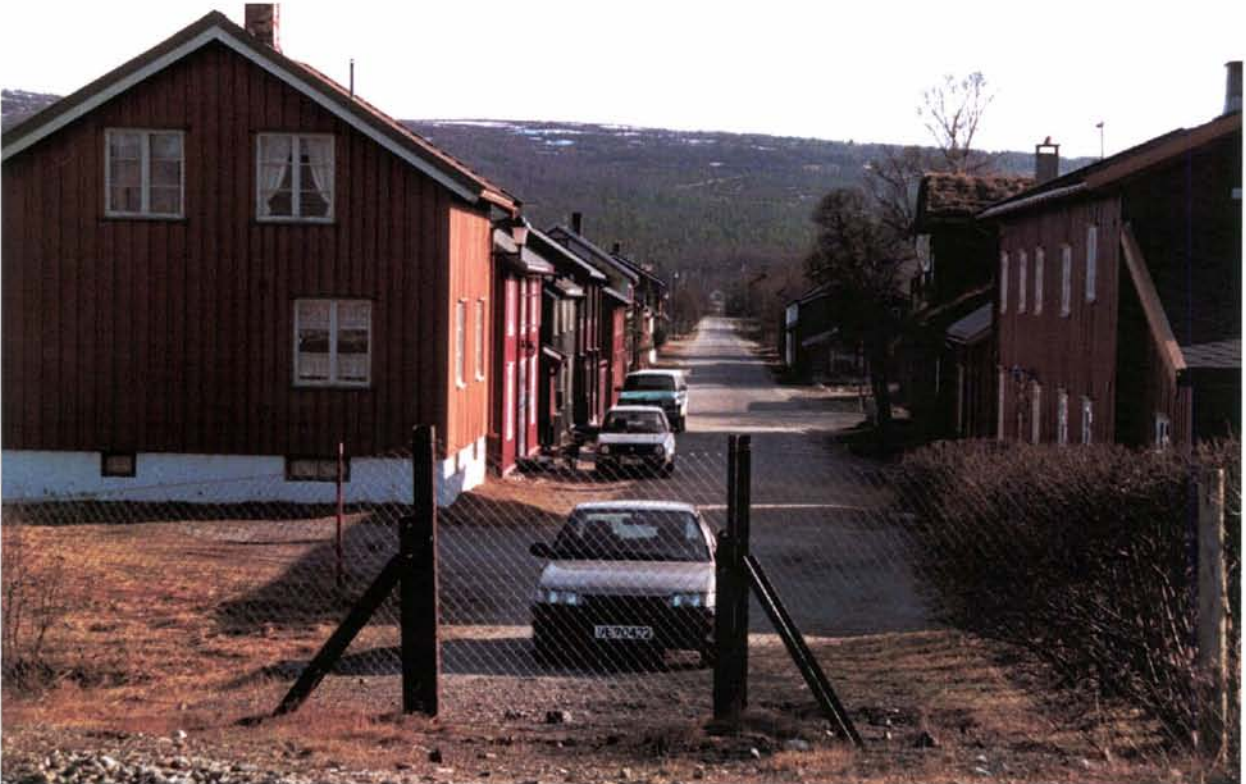
Foto 85 og 86: Vippegrinder på Røros slik de fortsatt sto i enden av gata på Øra for inntil få år tilbake (foto over). Slike overganger blir i dag systematisk sanert da de utgjør farlige kryssingspunkter på linja. De hører en annen tid til. Denne på Røros utgjorde imidlertid et historisk element i bydelen Øra. Overgangen ble anlagt for å kompensere for at gata som forbandt Øra med Bergstaden ble avskåret av jernbanen da denne ble bygget i 1944. Porten i gjerdet bør innsettes, selv om den holdes avstengt.
