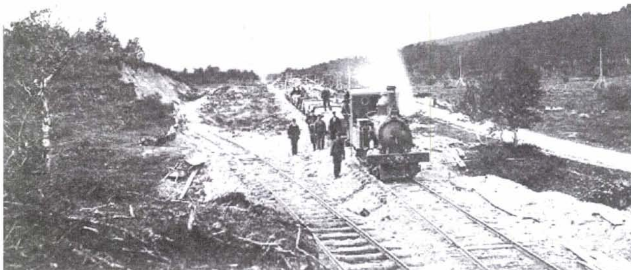
Foto 59: Grustog på Harborg. Fotoet er sannsynligvis fra grusingen i forbindelse med banens ferdigstillelse til Røros i 1876.
