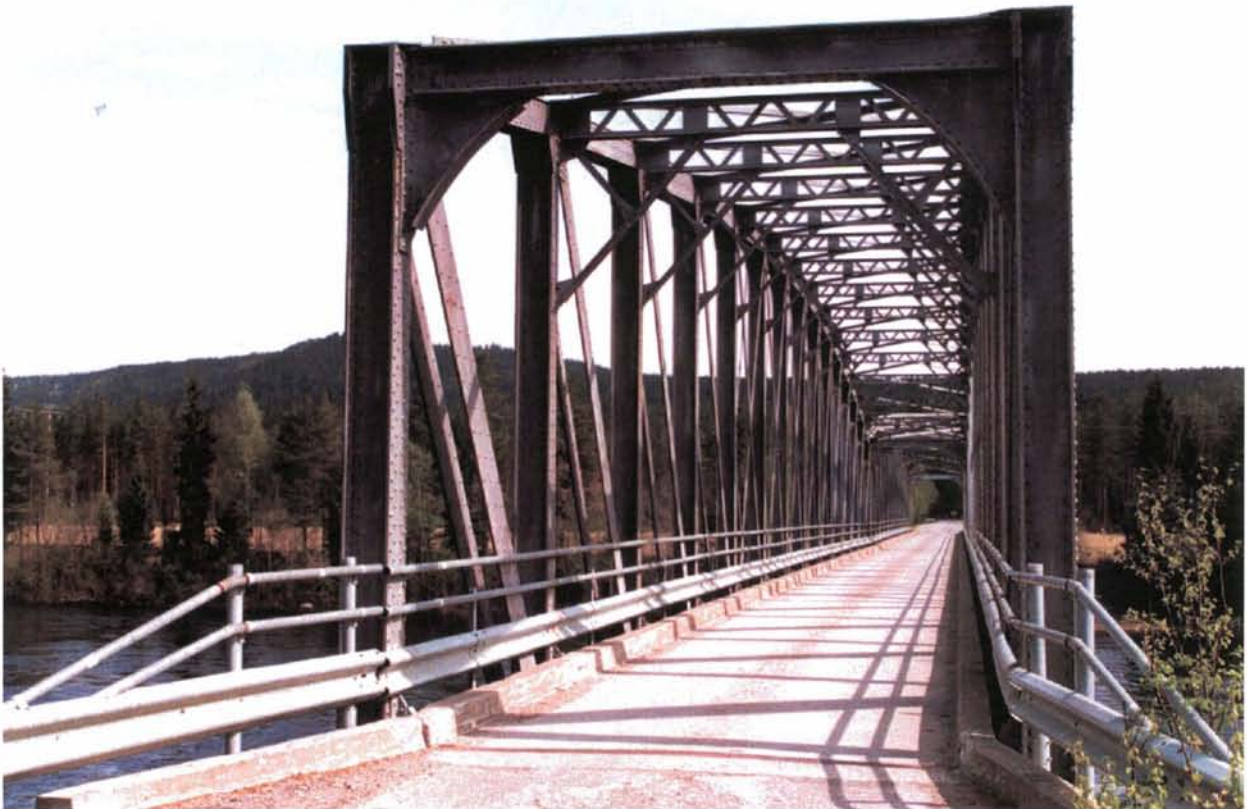
Foto 75: Gamle Steinvik jernbanebru er i dag gjort om til vegbru. Med unntak av brubanen er brua godt bevart. Statens vegvesen må sørge for at brua blir vedlikeholdt som teknisk kulturminne og unngå skilt og annet vegutstyr som kan forstyrre bruas arkitektur.
