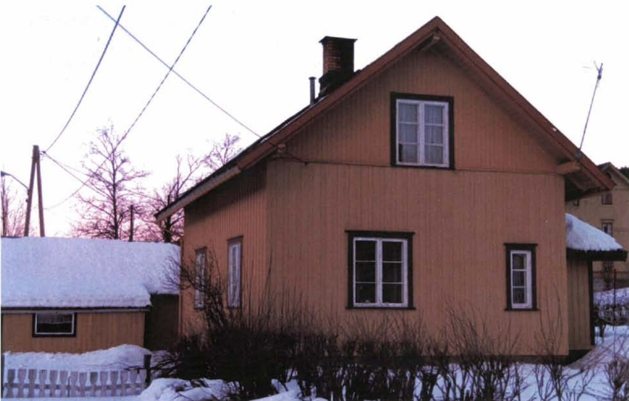
Foto 58: Stai vokterbolig fra 1898 er i dag i privat eie. Det er viktig at eiendommen med hus, hage, gjerder m.v. blir vedlikeholdt med sin tidskoloritt i behold som en del av det fredete bygningmiljøet på Stai stasjon (se side 30).
