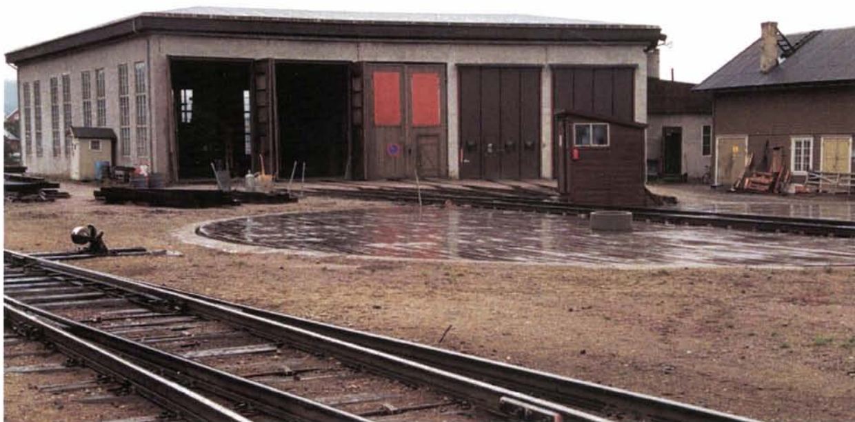
Foto 80: Rundstallen på Røros ble oppført i årene 1941-43, mens svingskiva er flyttet hit fra Drivstua. Stallen er base for banevedlikeholdet og brukes bl.a. til stalling av "gule maskiner". Selv om anlegget ikke pålegges noe formelt vern i "Nasjonal verneplan" er det viktig at bygningen og annen utrustning blir tatt vare på og vedlikehold med sin opprinnelige karakter i behold. Stallen bør få tilbake sine opprinnelige porter.
