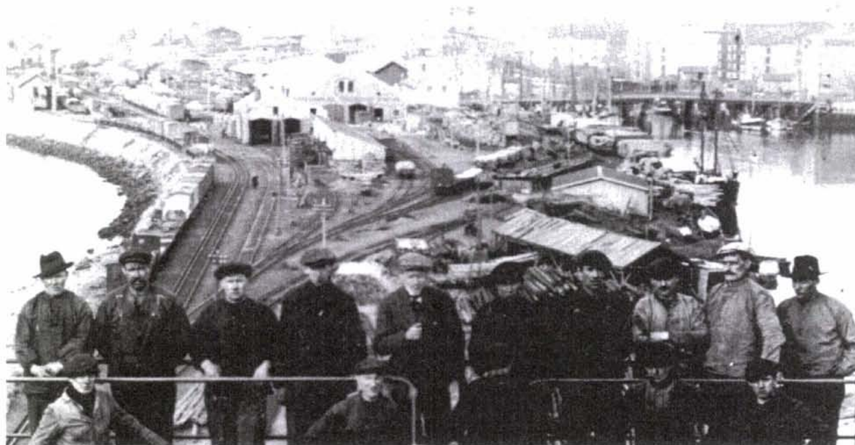
Foto 12: Fotoet viser Rørosbanens anlegg på Vestre tomt så sent som i 1917 med (f.v.) vognvekt, lokstall, kullskur, godshus og lastespor til kanalhavna. Stasjonstomta hadde adkomst via St. Olavs bru som ble revet etter at det nye stasjonsanlegget for Dovrebanen sto ferdig i 1921. Ingen av disse anleggene fra Rørosbanens opprinnelige stasjonsanlegg på Brattøra er bevart. Fotoet er tatt fra den nyoppførte Skansen bru på Dovrebanen. Denne ble tatt i bruk i 1918.
