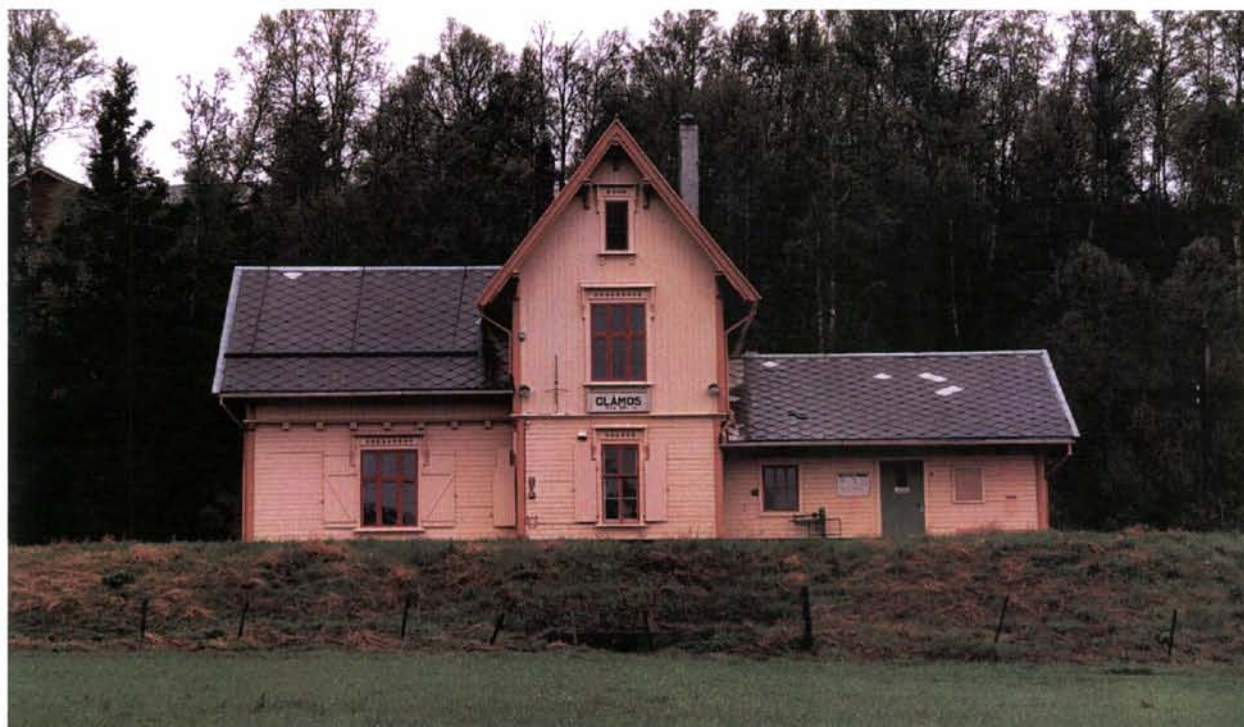
Foto 40: Glåmos er ett av de best bevarte stasjonsanleggene på Rørosbanen. Stasjonsbygningen, godshuset (begge tegnet av P. A. Blix i 1876), perrongen og stasjonsparken er fredet i medhold av Kulturminnelovens §§ 15 og 19 ved forvaltningsvedtak 12.03.1997. Et kjennetegn for mange av Blix' bygninger er den spisse takvinkelen – et trekk som også karakteriserer stasjonsbygningen på Glåmos. Anlegget framstår usjenert og eksponert i landskapet og er billedgjørelsen av den vesle fjellbygda.
