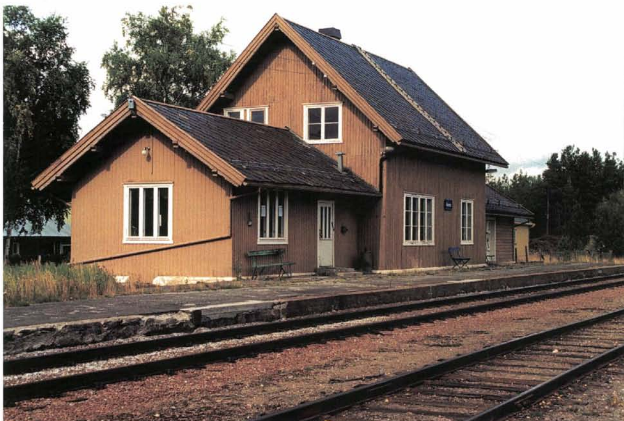
Foto 32: Stasjonsbygningen og den vesle husgrenda ved Auma står fortsatt som et minne fra jernbanens barndom. Anlegget er i god stand og stasjonsbygningen er administrativt vernet i "Verneplan for jernbanebygninger" som eneste representant for "Opphustypen". Om mulig bør stasjonsvernet utvides til også å omfatte bebyggelsen omkring (lokalt vern).
