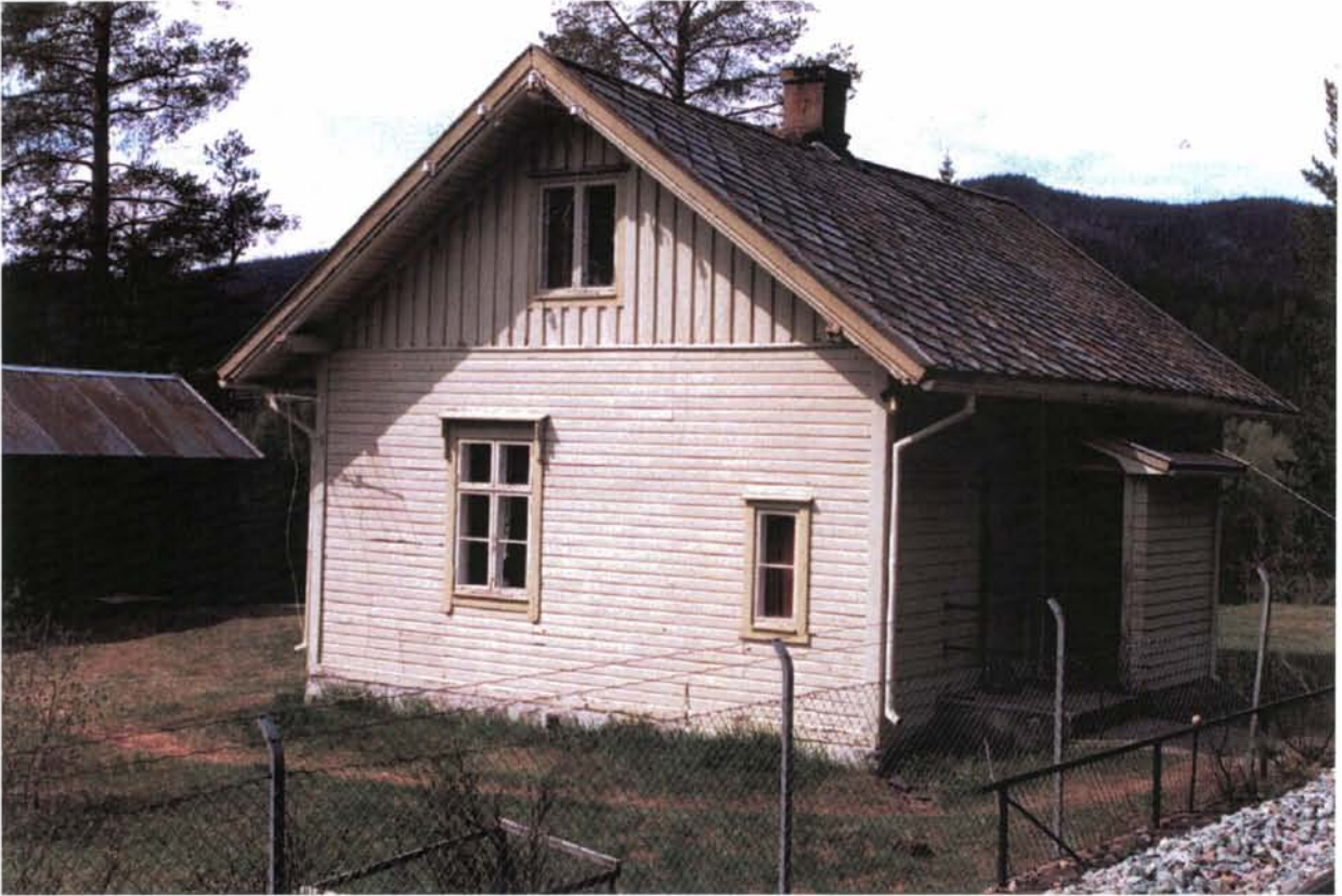
Foto 57: Søkunna vokterbolig, km 222,65, står på NSB's bygningsverneplan. Bygningen eies av NSB BA og brukes som feriebolig. Eiendommen ligger idyllisk til på en odde i Glomma like sør for Rasta. Skal bygningen bevares må den gis ny (sikker) adkomst over jernbanelinja.
