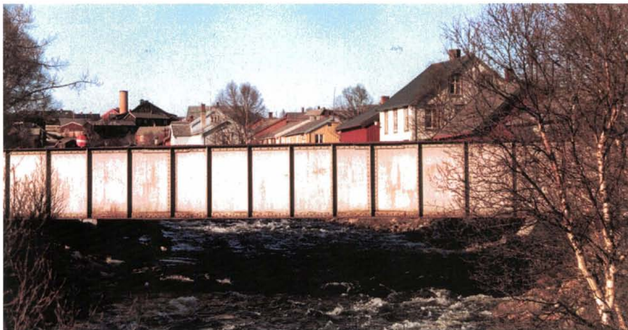
Foto 77: Brua over Hitterelva er utstyrt med høye, klinkede platebærere og dominerer på en uheldig måte elverommet mellom Flanderborg og Øra i gamle Bergstaden. Konstruksjonen med overliggende bæring ble nok i sin tid valgt på grunn av faren for isoppstuvning. Den bør erstattes av en mer transparent konstruksjon ved første anledning.
