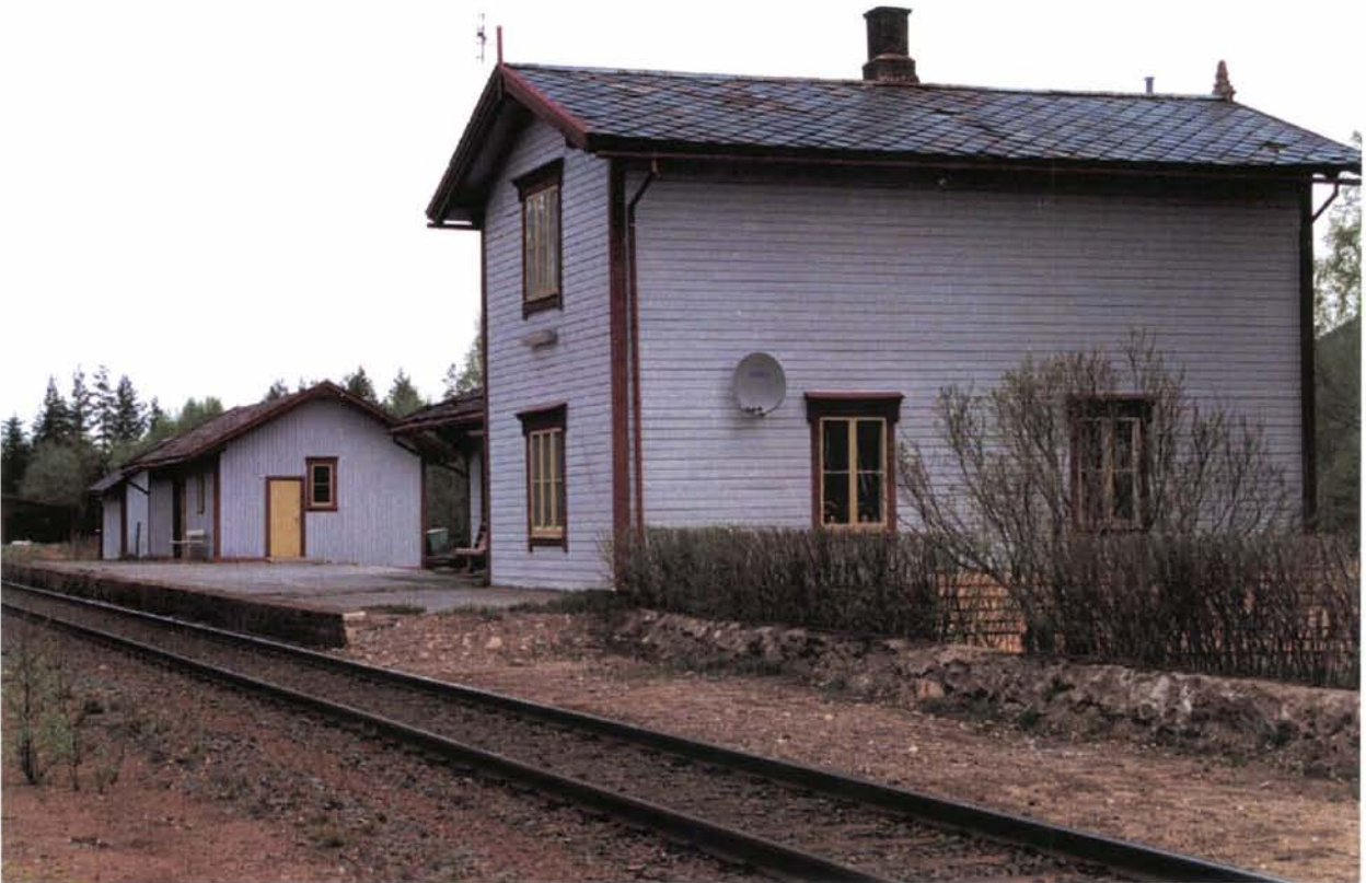
Foto 15: Steinvik stasjon har et komplett og opprinnelig bygningsmiljø fra 1873-75. På grunn av dette er hele seks bygninger ved stasjonen oppført på NSB's "Verneplan for jernbanebygninger". Av disse er stasjonsbygningen, godshuset, privèten og bryggerhuset foreslått fredet (frednings-sak igangsatt 24.11.2000). Tiltak utført på bygninger og plattform har imidlertid redusert anleggets autentiske verdi.
