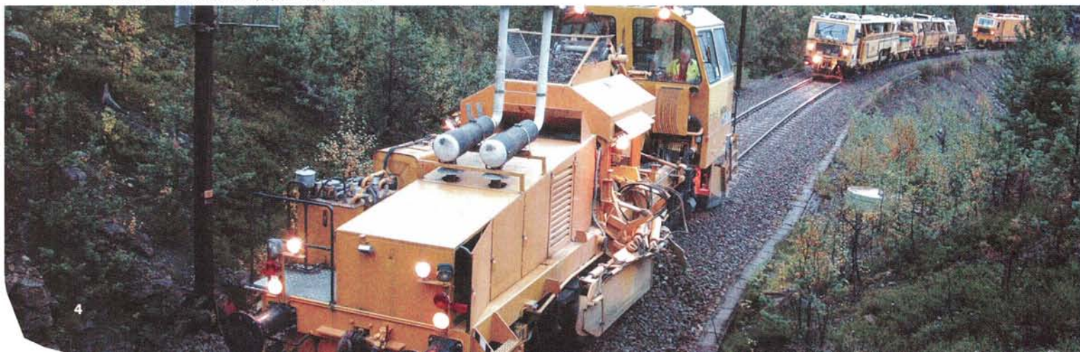
Maskiner for vedlikehold ved Mjølfjell. Foto: Øystein Grue
