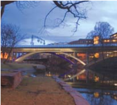
De nye jernbanebruene over Sandvikselva i sentrum av Sandvika. Foto: Rune Fossum
