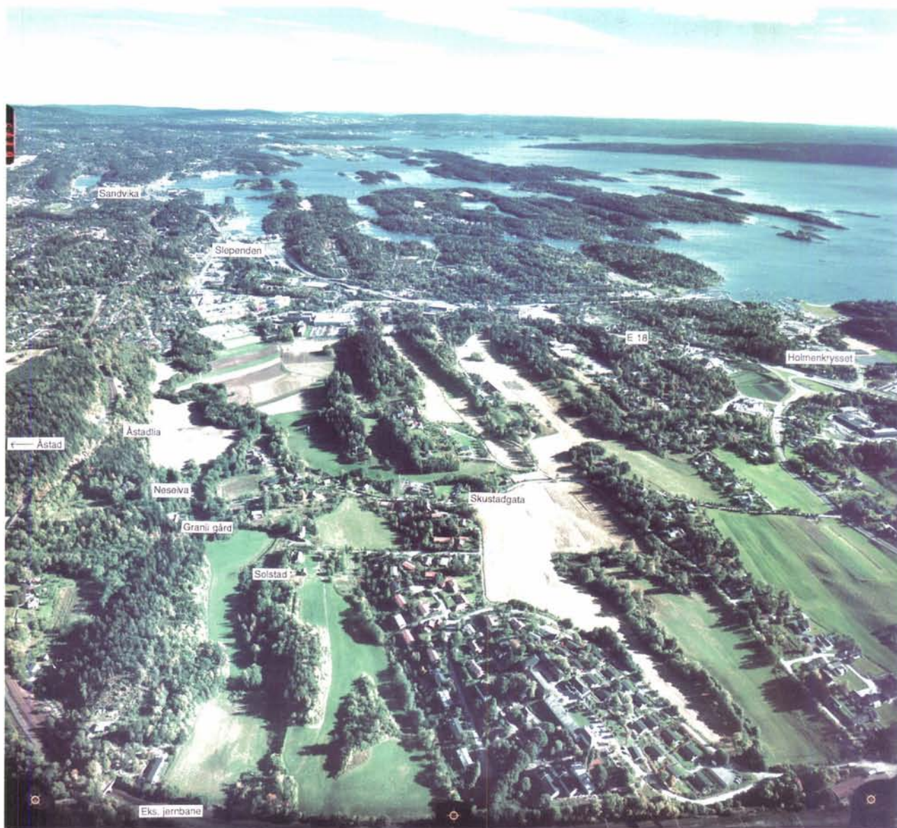
Figur 30 Flyfoto av ytre del av Vestkorridoren, Asker Foto: Fjellanger Widerøe A/S
