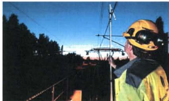
Vedlikehold på kontaktledning
