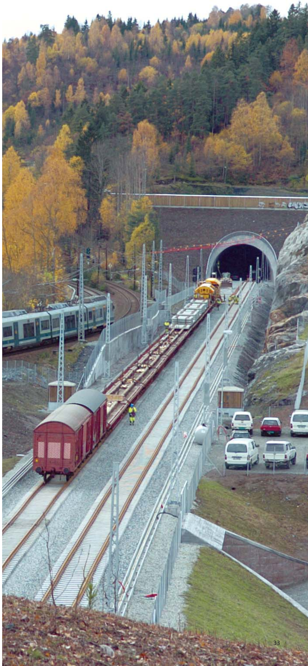
Utbygging Sandvika - Asker, sporlegging mellom Tanumtunnelen og Skaugumtunnelen. Foto: Øystein Grue
