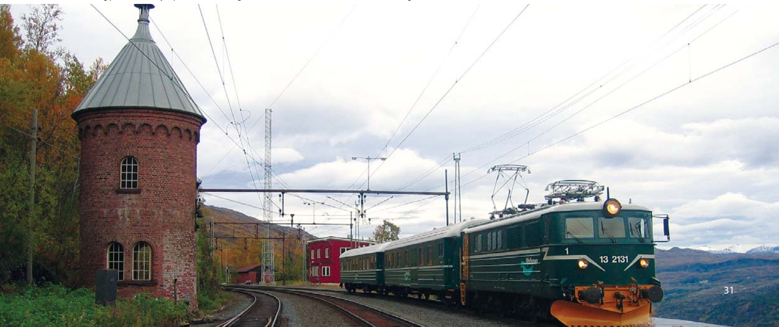
Persontog på Rombak stasjon på Ofotbanen. I bakgrunnen: GSM-R-mast. Foto: Ofotbanen A/S, Jan Haugen
