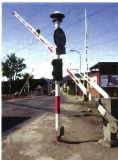
Veisignalanlegg Mot veien
