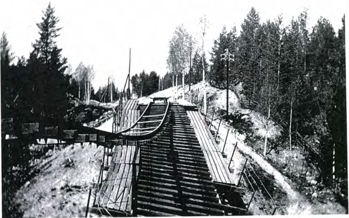
Kjölsjøbekk bru etter sprengningen:
