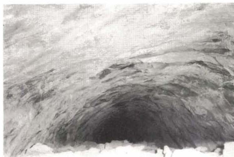
Forsiktig sprengt tak. Sprengt med listeladninger.
