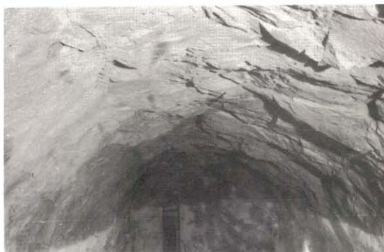
Forsiktig sprengt tak. Sprengt med geomitt løst pakket .
