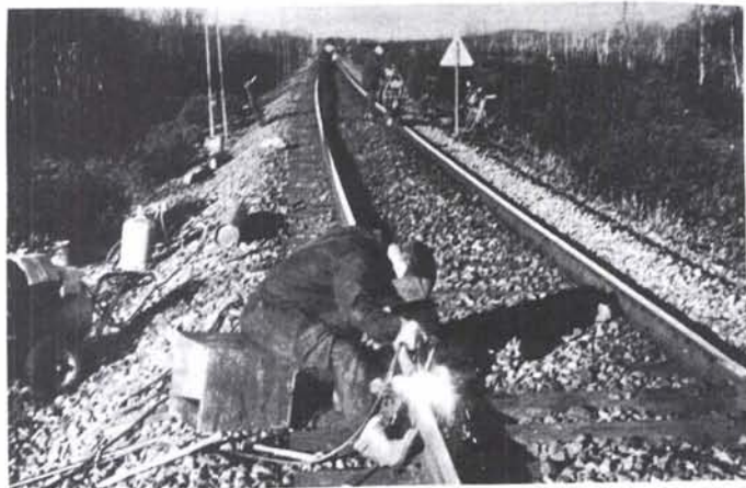
Fig. 124. Påleggsveising med lysbue.
