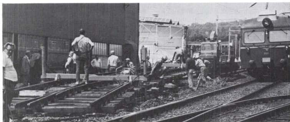
Fig. 121. Ferdig sporveksel nedsenkes i sporet.
