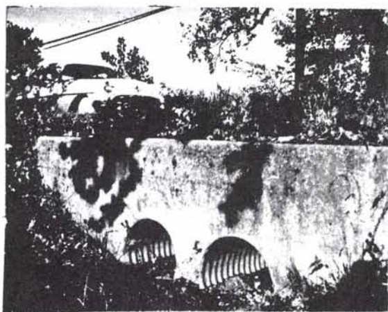
Fig. 88. Stikkrenne av bølgede stålplater.
