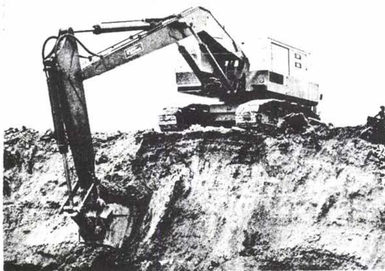
Fig. 16. Hydraulisk styrt gravemaskin med bakgraverutstyr.
