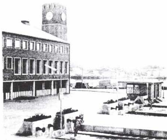
Fig. 187. Støpte endestoppere (Bodø).
