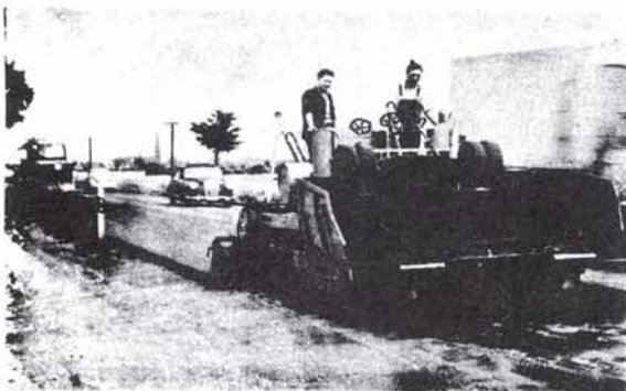
Fig. 191. Legging av asfaltdekke.
