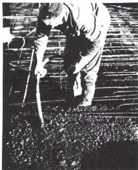
Fig. 27. Vibrering av dekkstøp med stav vibrator.
