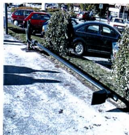
Det finnes nedfellbare lysmaster på markedet. (Armaturen som er vist her er ikke Jernbaneverkets standard).
