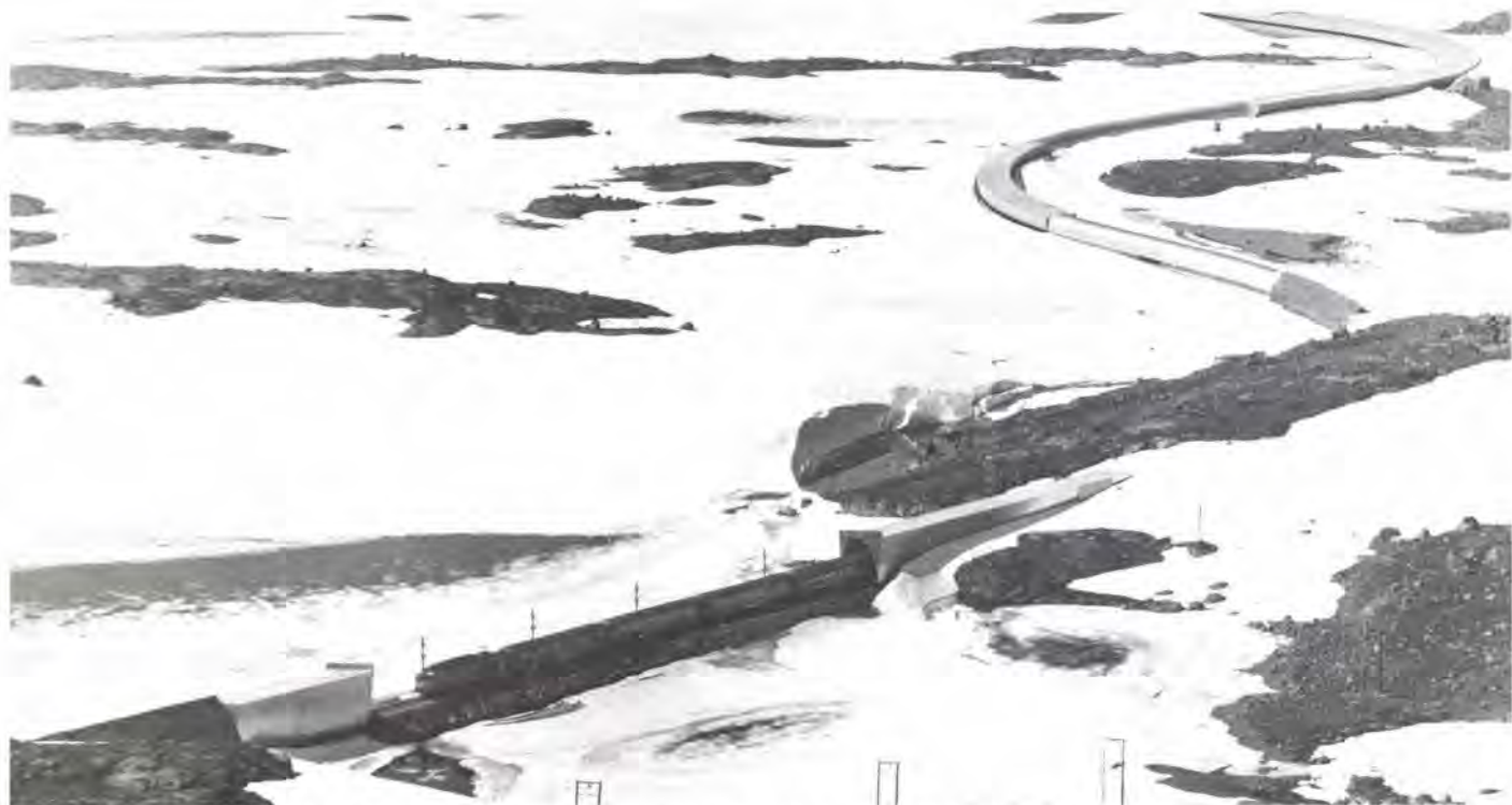
Kilometer på kilometer med snøoverbygg beskytter Bergensbanen på den værharde høyfjellsstrekningen.
