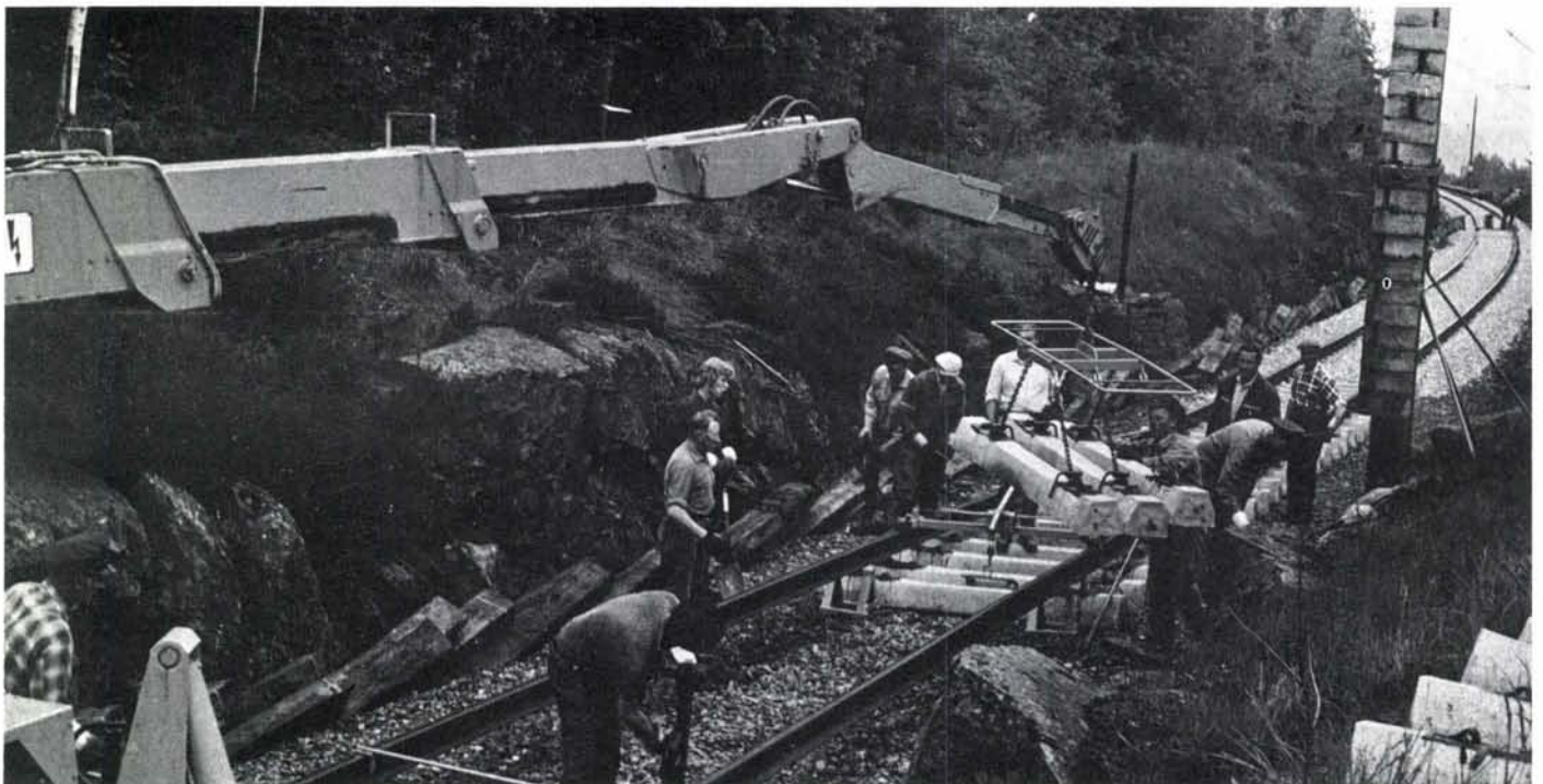
Effektive metoder for innlegging av betongsviller er under stadig utvikling.
