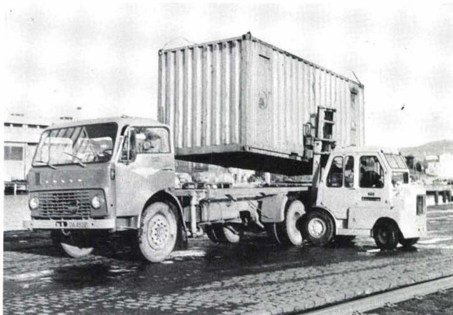
NSB Biltransport overfører containere fra båt til bil til bane.
