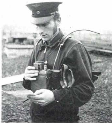
Bærbart radioutstyr i bruk på Alnabru
