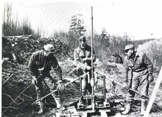
Prøver av grunnen tas med stempelbor.
