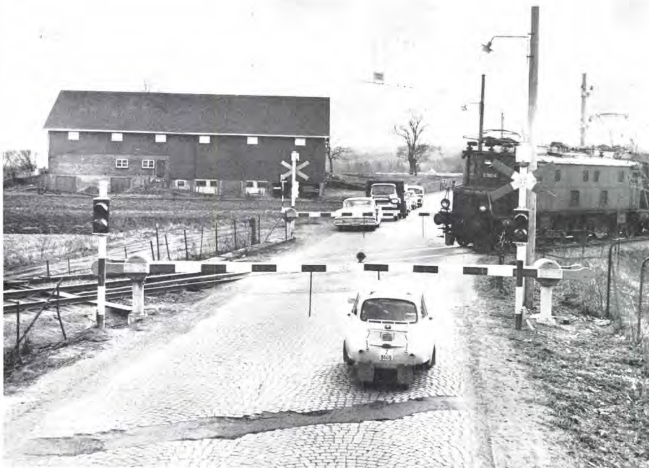
Automatisk vegbomanlegg ved Borre.
