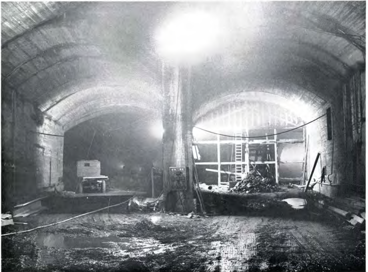
Fra arbeidet med den nye lok.stallen i Lodalen, Oslo Ø.
