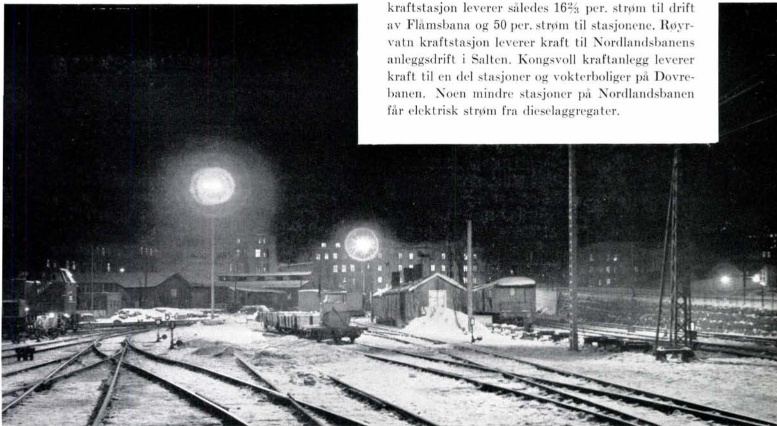
Tomtebelysning (natriumdampplamper), Oslo Ø.
