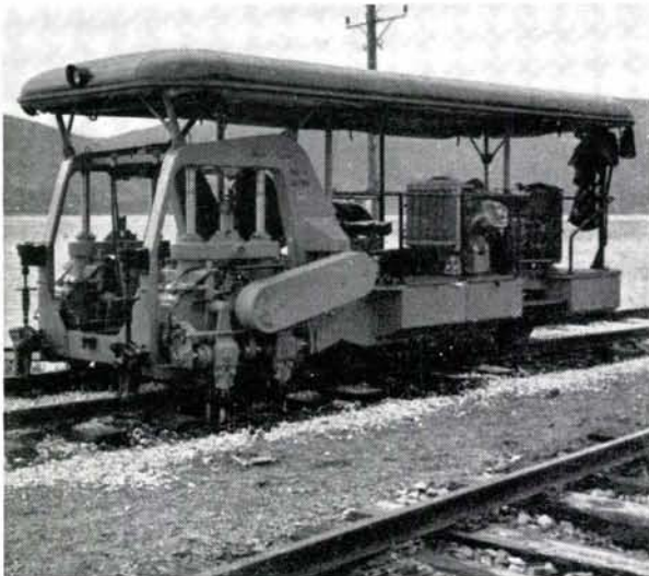
Automatisk svillepakkemaskin. Pakker opptil 350 l. m. spor pr. t.
