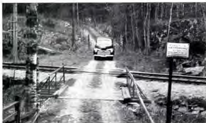
En av de ca. 9000 private planoverganger. Forsiktighet må utvises. Beskyttelsen er bare en ubevoktet grind.
