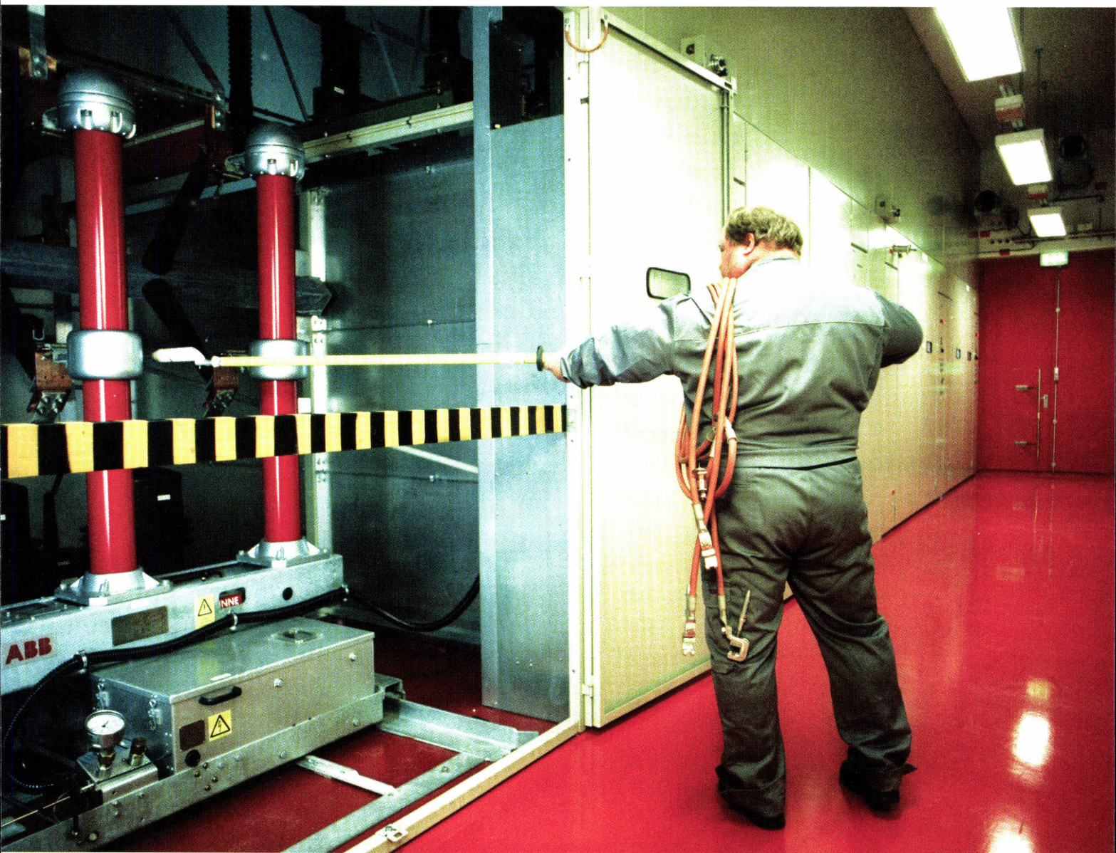
Maskinsjefassistent Trond Jørgensen spenningsprøver og jorder på 47 kV før arbeidet kan utføres.
