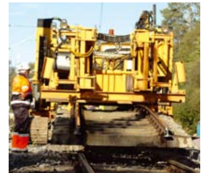
Desec vekselutlegger under arbeid ved Roven kryssingsspor. Foto: Magne Hamar
