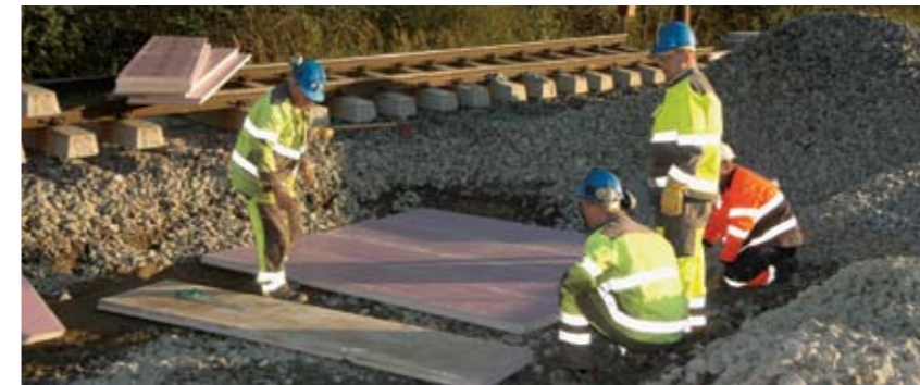
Arbeid med underbygging ved Roven kryssingsspor. Foto: Magne Hamar
