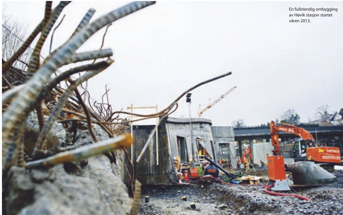
Våren 2014 begynner selve underbygningen under sporene på Høvik å ta form. En rekke støttemurer, ramper og trapper er også på plass.
