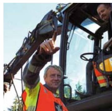
Oppsynsmann Bjørn Jensen er sikkerhetsmann mens maskinkjører Per Erik Lindsetmo rydder vegetasjon langs linjen. Foto: Øystein Grue
