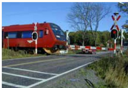
Halvbomanlegg / Half barrier
