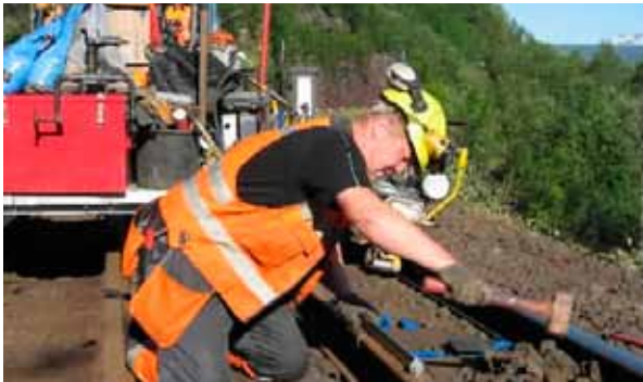
Vedlikeholdsarbeid på Ofotbanen, juli 2007. Foto: Thor Brækkan
