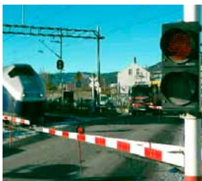
Planovergang med automatisk heilbomanlegg. Foto: Njål Svingheim
