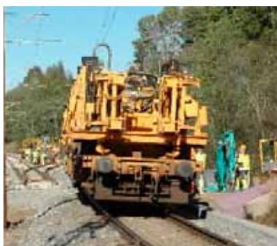
Skinneleggingsmaskin ved Roven kryssingsspor. Foto: Magne Hamar
