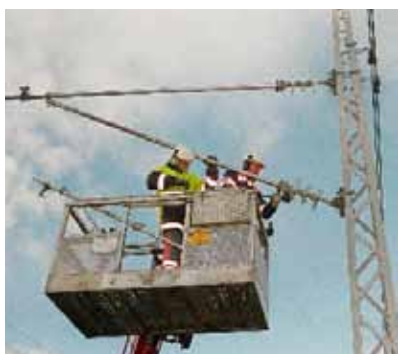
Montering av kontaktledningsanlegg Sandvika - Asker. Foto: Magne Hamar
