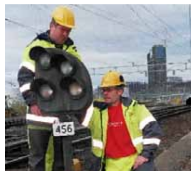
Arbeid på dvergsignal ved Oslo S. Foto: Terje Kristiansen
