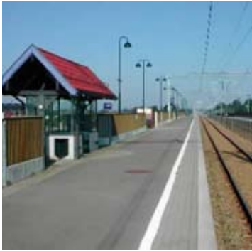
Rygge stasjon med leskur og plattform. Foto: Njål Svingheim
