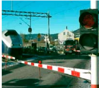
Planovergang med automatisk heilbomanlegg. Foto: Njål Svingheim
