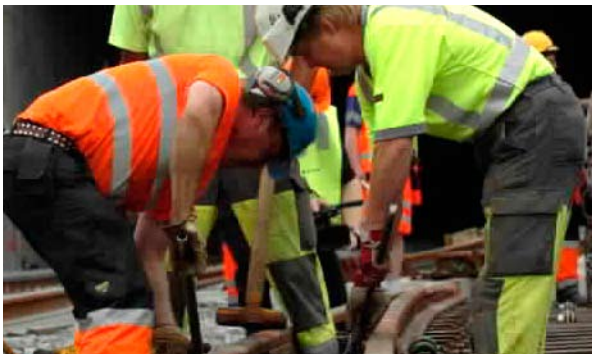
Arbeid på sporet ved Asker stasjon. Foto: Øystein Grue
