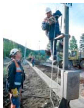
Montering av skilt ved Guklsvik kryssingsspor. Foto: Øystein Grue
