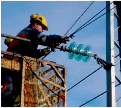
Montering av kontaktledningsanlegg. Foto: Øystein Grue
