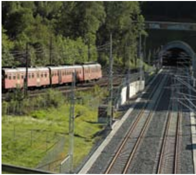
Gammelt og nytt dobbeltspor side om side ved Solstad i Asker. Foto: Øystein Grue
