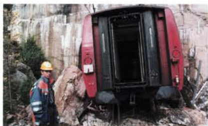
Ras ved Gjerstad tunnel, Aust-Agder
