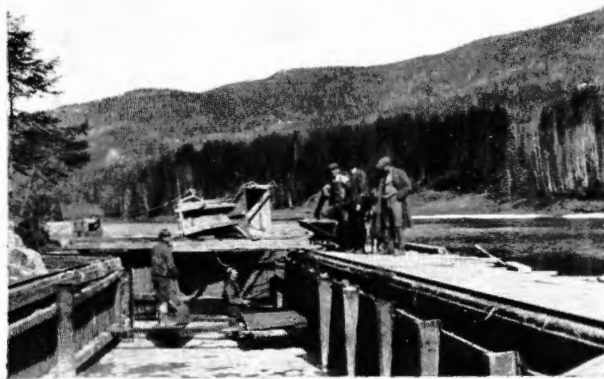
Fundamentstøpning. Brohaug bro.
