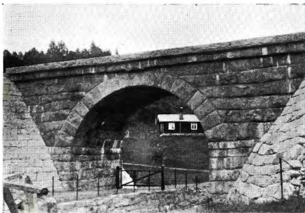
Bro over vei og bekk ved Helle.
