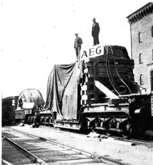
Deler til generator for 29000 kVA maks. Vekt 40 t. Opladet og under oplastning på 6 akslede spesialvogner.
