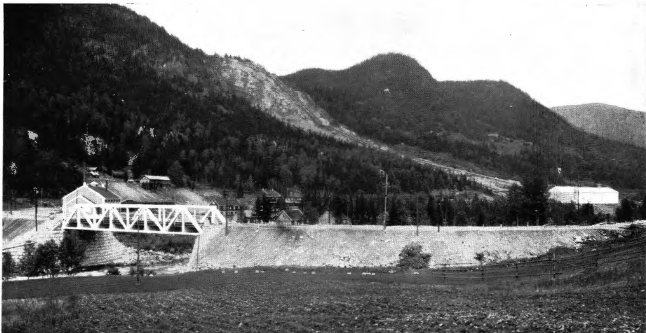
Kombinert vei- og jernbanebro over Opdalselven ved Rødberg st. I bakgrunnen sees Noreanleggets rørgate og kraftstasjon.
